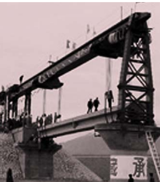
Bau einer Eisenbahnbrücke
